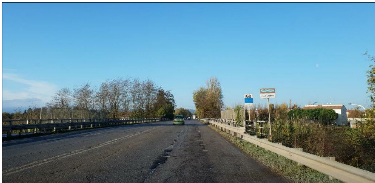
Foto 5 - Area di intervento - Via Trento con ponte su Fiume Lamone
