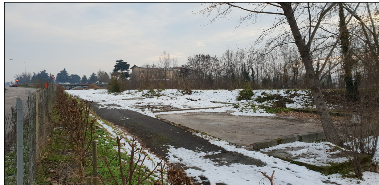
Foto 2 - Area di accantieramento, Via Renaccio presso accesso/uscita da via Piave (Circonvallazione di Faenza-SS9)
