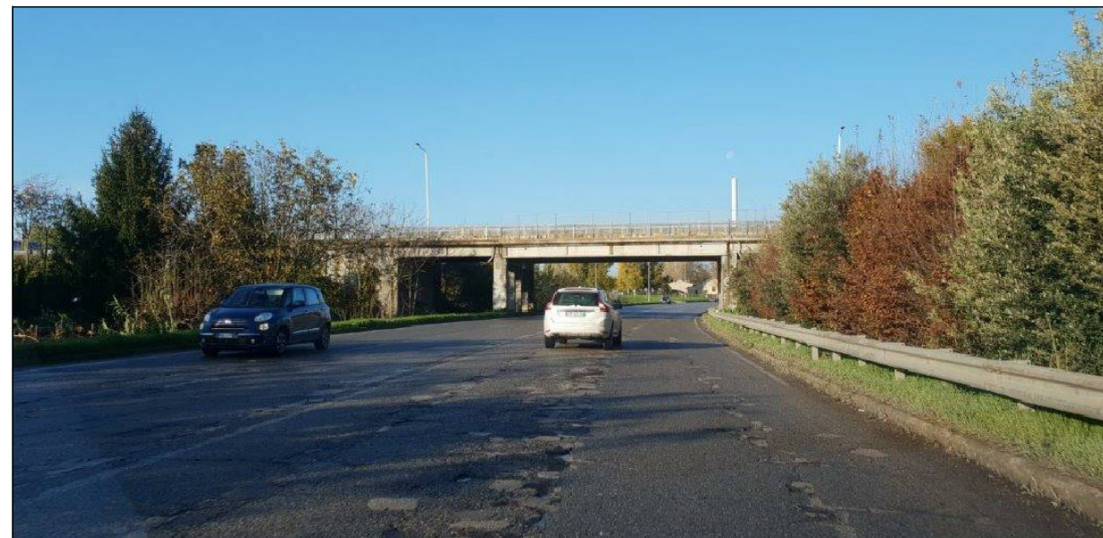
Foto 6 - Area di intervento - Via Trento con sottopasso Via G. Ballardini
